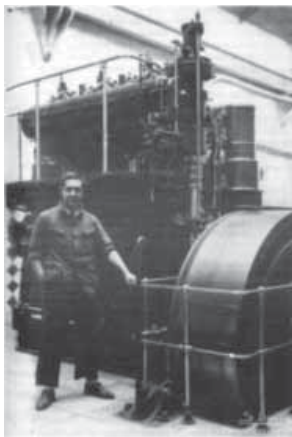
Jorge Gomes Vieira ao pé dos geradores da Imprensa Nacional
