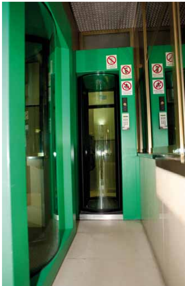
Leitores para abertura das portas, com banda magnética e dados biométricos, e portas de segurança de acesso à zona de alta segurança.
